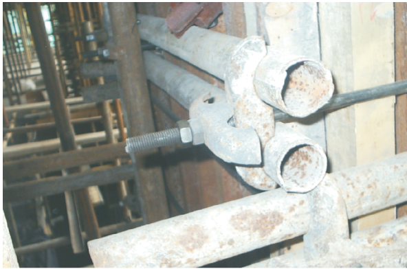
图3-4 基坑东侧34轴外墙外侧模板构造图
